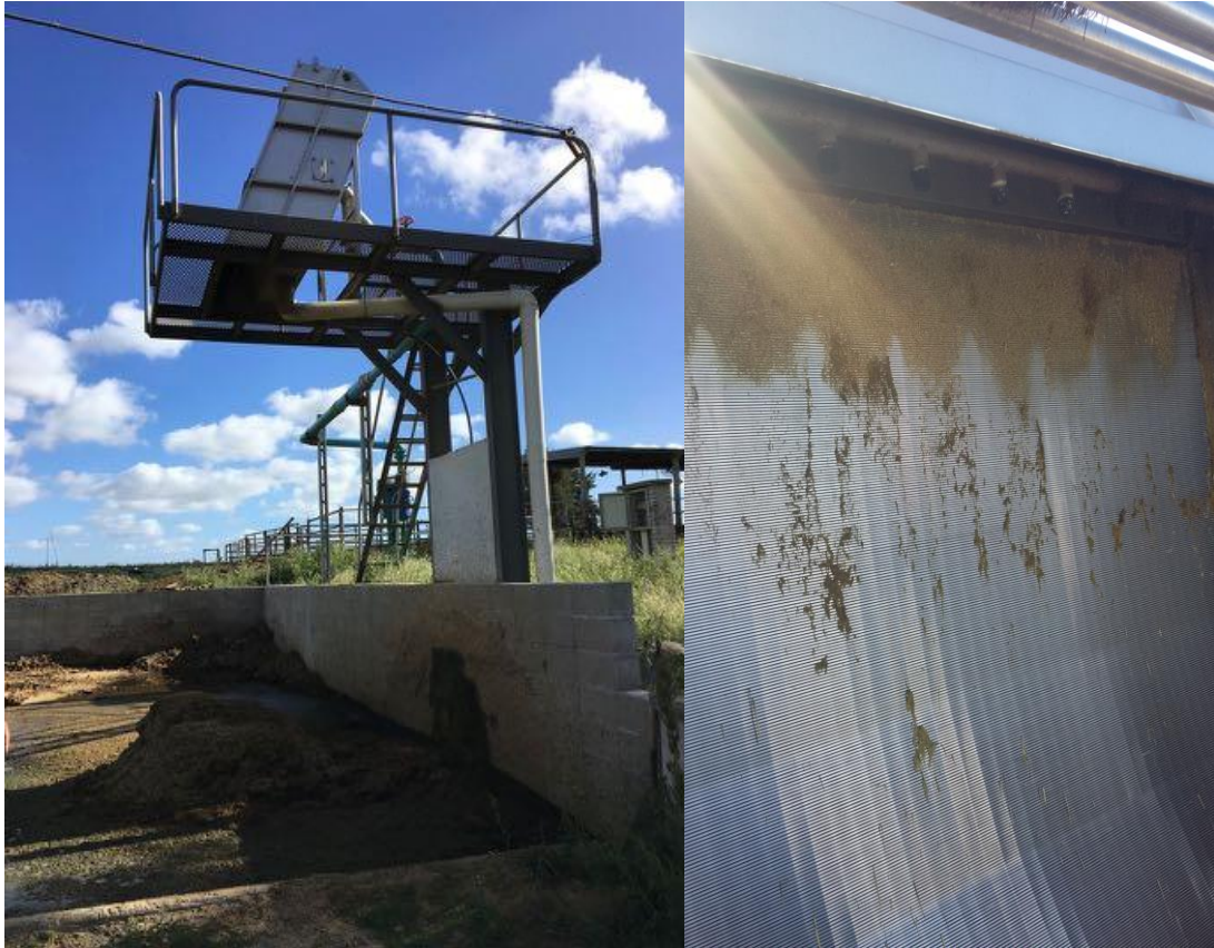
Figura 16. Caso 5, Tamiz. Izquierda: vista general de la instalación; derecha: detalle de la malla
